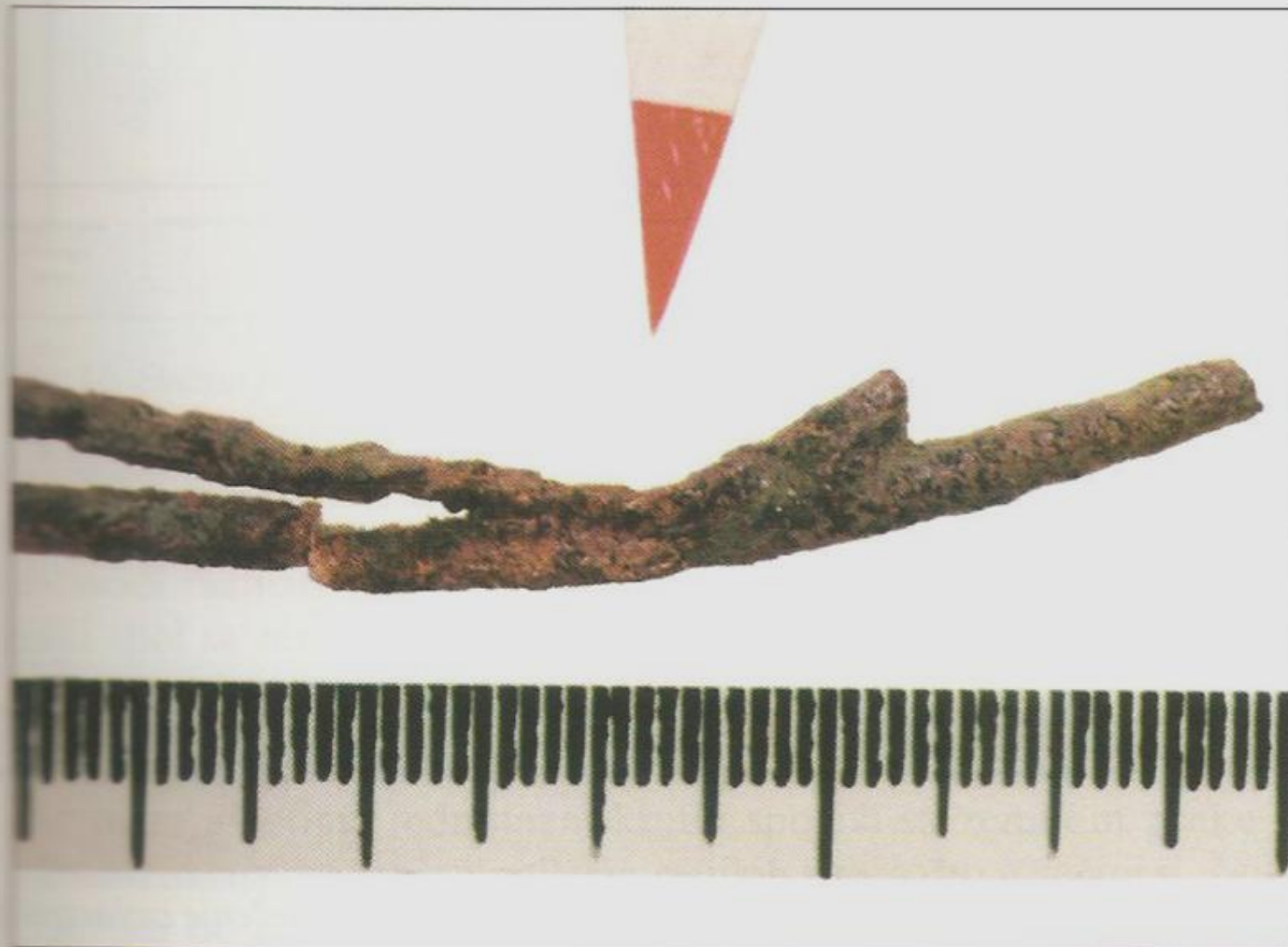
Slika 14. Fotografija na kojoj su vidljivi tragovi taljenja bakrenog vodiča zbog razvijene topline nastale požarom. Uočava se da je trag šireg razmjera, nema određene granice, a na krajevima dolazi do smanjenja poprečnog presjeka vodiča. Površina taljenog vodiča izgleda kao da je obrasla školjkama.
