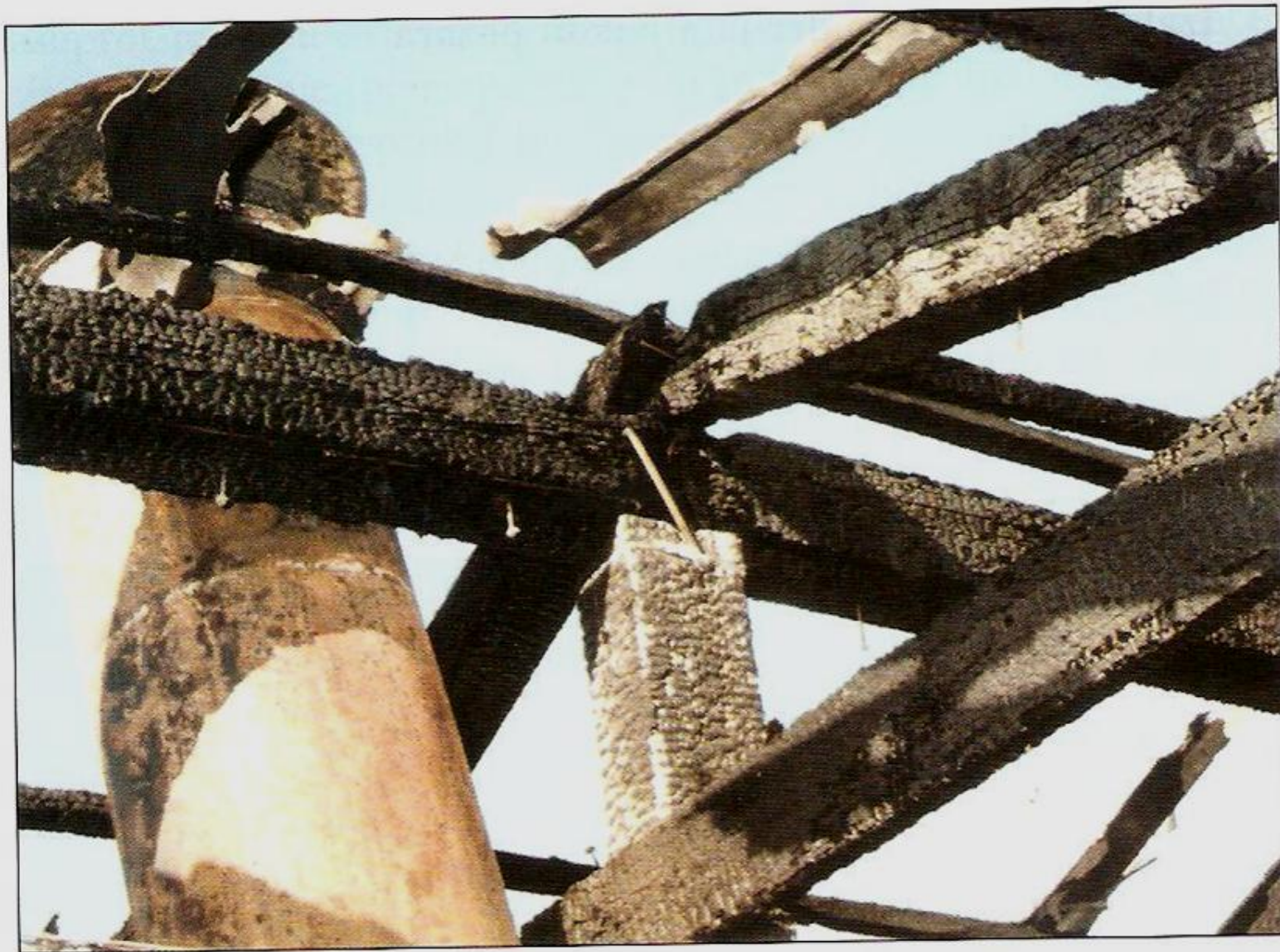
Slika 38. Prikaz krokodilske kože-izgaranje greda. Po ovim tragovima moguće je procijeniti vrijeme trajanja požara, kao i smjer širenja plamene fronte.
