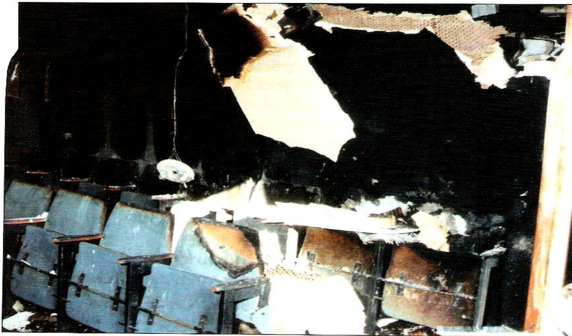
Slika 36. Vidljivo je da je po intenzitetu oštećenja sjedala moguće utvrditi smj širenja plamene fronte.
