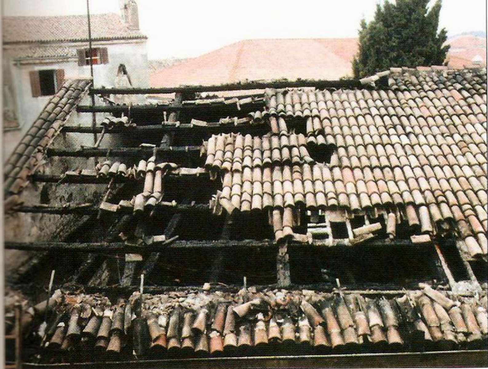
Slika 32. Izgled krovišta nakon događaja požara. Vidljivi su tragovi proboja što ukazuje na mjesto gdje je požar bio najintenzivniji.
