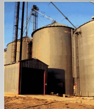
skladištenje u čelične ćelije
