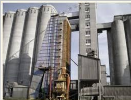
skladištenje u betonske ćelije
