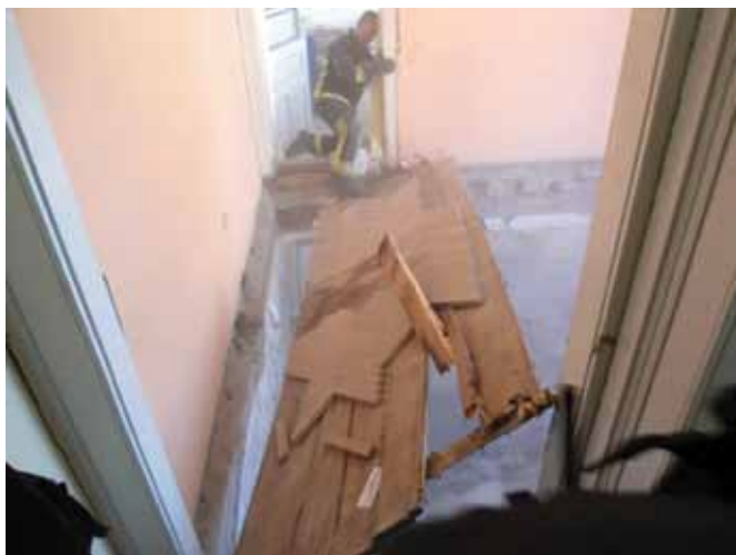
Vatrogasnu je intervenciju otežavala činjenica da je u prvih pola sata postojala opasnost od eksplozije kao i opasnost od udara el. energije
